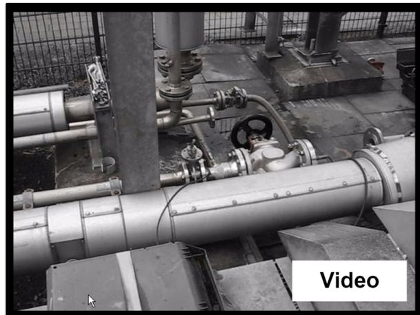
Bild 13: Versuchsventil am Ende der Stichleitung [7]
